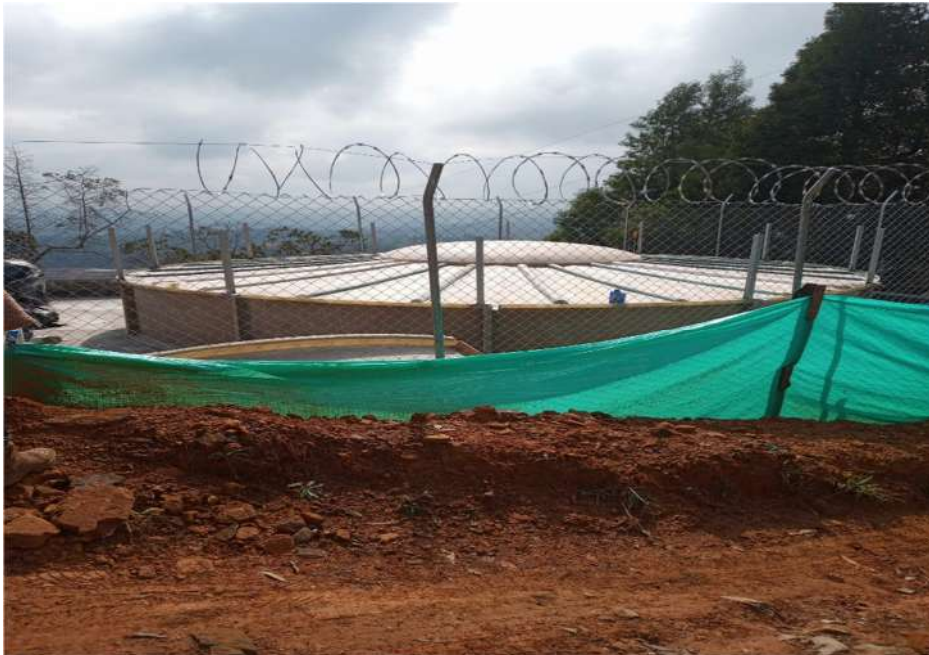
Construcción tanque y cerramiento.
