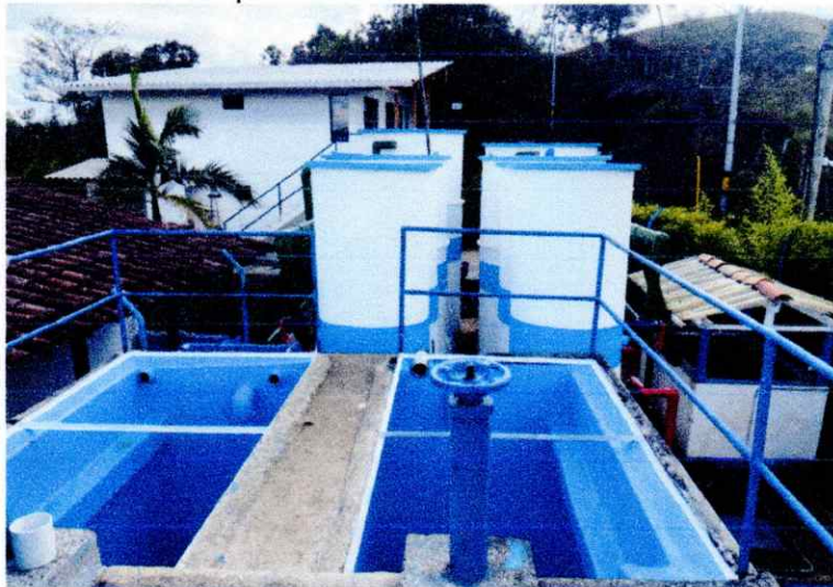
recubrimiento tanques de filtro
