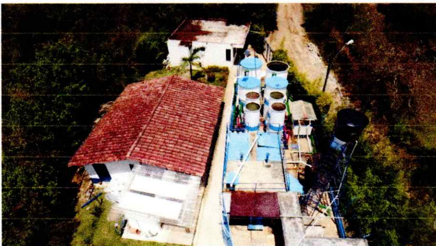
Vista aérea. Reforma y ampliación planta de tratamiento.
