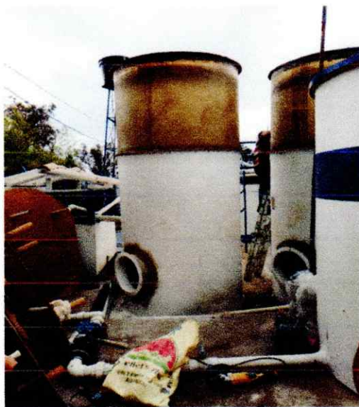
proceso de ampliación PTAP
