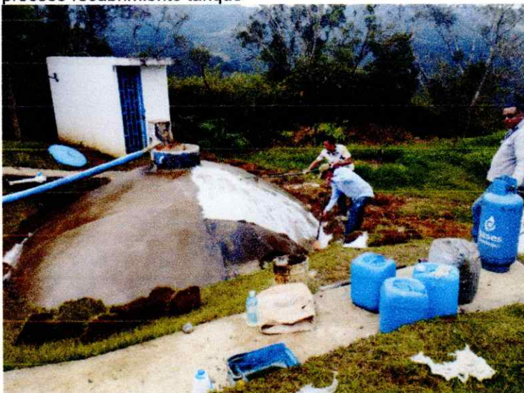
proceso recubrimiento tanque
